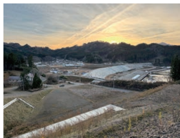
植樹した高台より箱崎地区を眺める。 防潮堤のすぐ左が、薪割り場
