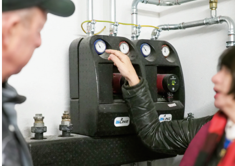
左：どこかに異常がないかが確認できる 管理室のPC画面 右：ヨハンさんの自宅敷地内にあるボイ ラー室
